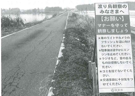
写真3 注意看板と問題となっている堤防
