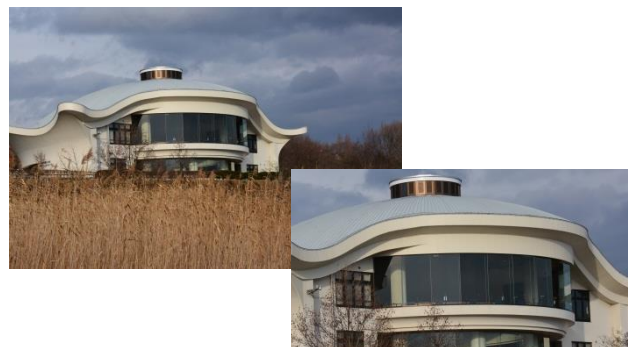
工事終了後のようす
